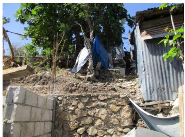
*A gauche, la construction des premiers murs. A droite, le mur de renforcement pour éviter les éboulements et chutes de pierres et l'écoulement des eaux du haut à travers la maison.*
