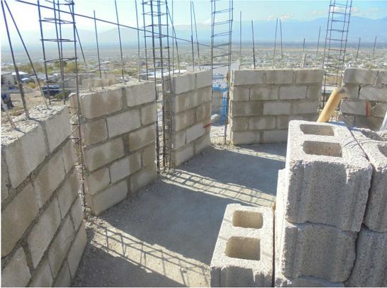
Le chantier durera un peu moins de deux mois. La construction du réservoir d'eau a bien avancé au bout de 6 semaines. On voit les douze colonnes de béton armé. La citerne domine la plaine du Cul de Sac, en bas. Elle sera visible de loin. Les ouvriers travaillent en continu pour respecter les délais prévus.
