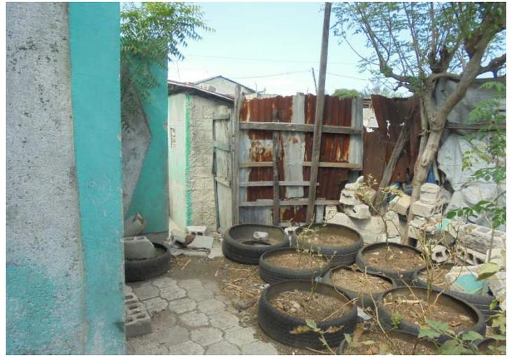
Ci-dessus, image 1 : Les gravats à enlever. A gauche un espace en ruine à éliminer pour y construire un mur. Jusqu'à la construction, nous hébergions dans cet espace une famille qui n'avait pas de logement. Au fond, un mur, mal construit, fragilisé par le séisme qu'il faut démolir et reconstruire. A droite de l'image : un mur qui sépare l'école des bâtiments de Sakala, qu'il faudra renforcer pour y adosser les 6 toilettes nouvelles.
